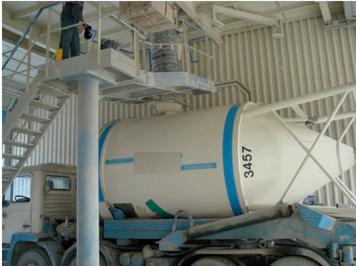
Bild 1: Ortsfeste Beladestelle transportabler Silos
