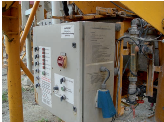
Bild 5: Steereinheit mit Hauptschalter und Hinweisen zum sicheren Betrieb.
