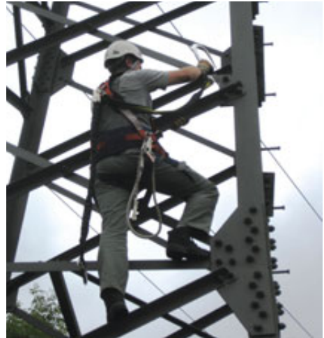
Abb. 39 Beispiel für den Einsatz zweier Verbindungsmittel gemäß Abb. 29 mit integrierter Falldämpffunktion.
