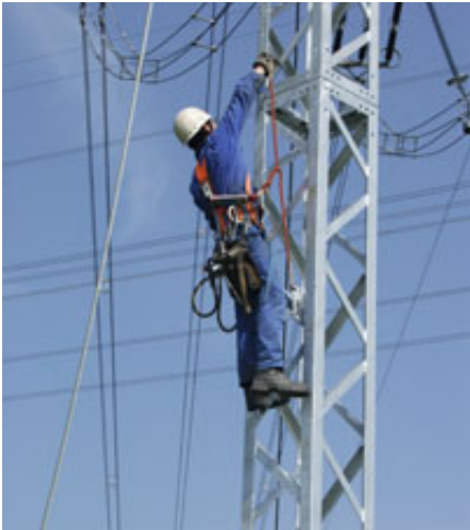
Abb. 38 Beispiel für den Einsatz eines Y-Seiles gemäß Abb. 26 beim Besteigen eines Notgestänges.
