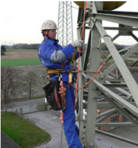
Abb. 13 Nach gesichertem Aufstieg am Mastschaft durch die Verwendung eines mitlaufenden Auffanggerä- tes an beweglicher Führung steigt der Versicherte auf eine Traverse um. Vor dem Lösen des Auffang- gerätes hat sich der Versicherte mittels Verbind- ungsmittel an der Traversenkonstruktion gesi- chert. Der Einsatz des Halteseils stellt keine Maßnahme zum Schutz gegen Absturz dar und dient lediglich der Positionierung des Versicherten am Arbeitsplatz.
