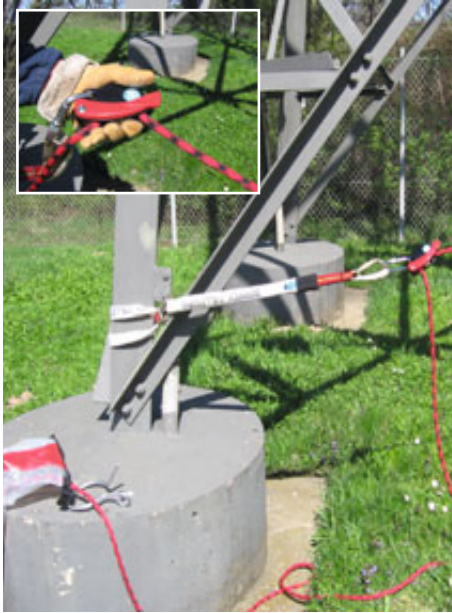
Abb. 42 Beispiel für ein am Mastfuß installiertes Sicherungsseil mit „Sicherungsgerät“. Das Seil wird entsprechend dem Aufstieg aus dem Transport-sack nachgeführt.
