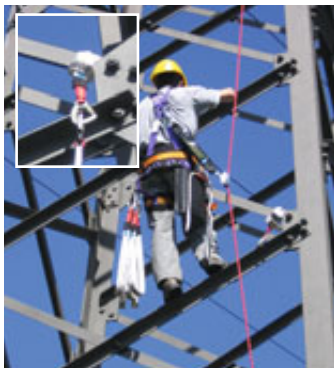
Abb. 44 Nach Befestigung des Sicherungsseils an einem Anschlagpunkt können weitere Versicherte mittels mitlaufendem Auffanggerät können den Mast besteigen.
