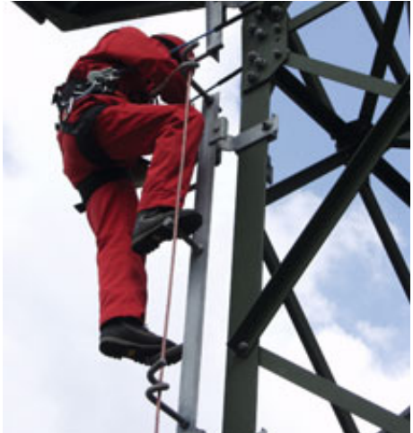
Abb. 10 Beispiel für den Einsatz von Steigbolzen mit Sicherheitseinrichtung am Eckstiel eines Gittermastes.
