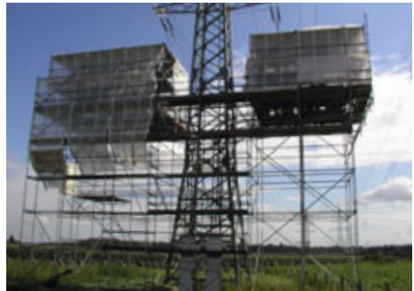
Abb. 3 Einsatz eines Gerüsts zur Montage von Kabelendverschlüssen an einem Freileitungsmast
