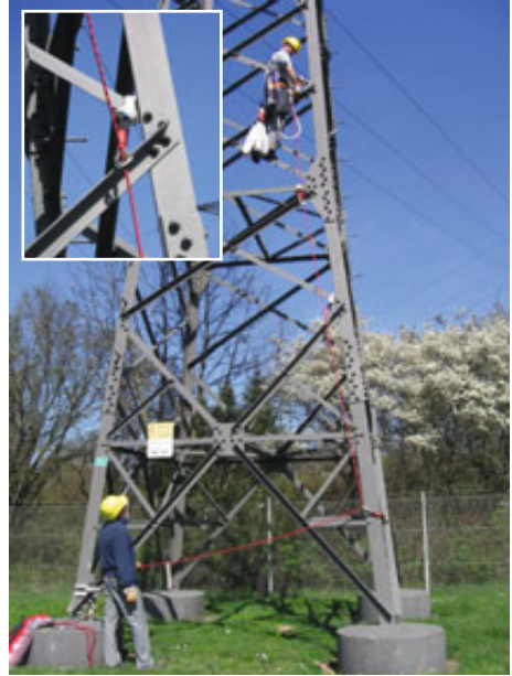
Abb. 43 Der erste aufsteigende Versicherte installiert mit Bandschlaufen und Karabinerhaken Anschlagpunkte und hängt das Sicherungsseil in diese ein. Während des gesamten Aufstiegs ist er an einer Auffangöse seines Auffanggurtes am Sicherungsseil gesichert. Der Versicherte am Boden führt die erforderliche Seillänge nach. Im Absturzfall blockiert die Seilbremse das nachlaufende Sicherungsseil. Ein Retten ist durch weiteres Nachlassen des Sicherungsseils unmittelbar möglich.
