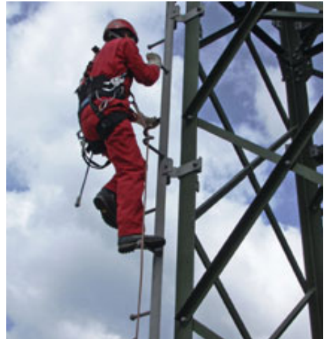
Abb. 46 Beispiel für einen Steigbolzengang. Um die Absturzhöhe möglichst gering zu halten, ist hier jeder vierte Steigbolzen mit einer Sicherheitseinrichtung ausgeführt.
